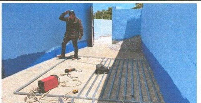
Foto 5: Trabajos preliminares a cambio de estructura metálica
