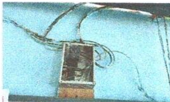
Foto 9: Sustitución de tablero de flípones
