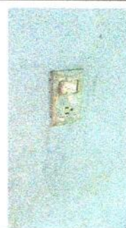
FOTO 5: Sustrucción de interruptores dobles
