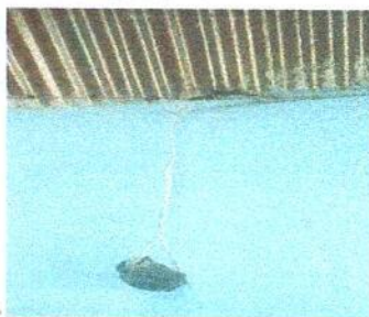
Foto 11: Sustitución de ducto eléctrico + accesorios
