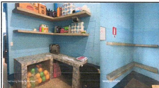
Foto 10: instalacion de meson y estantes de concreto para almacenar enseres, en bodega.
