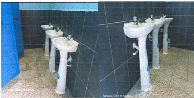
Foto 5: sustitucion de accesorios de lavamanos y fijar la base sobre el piso.
