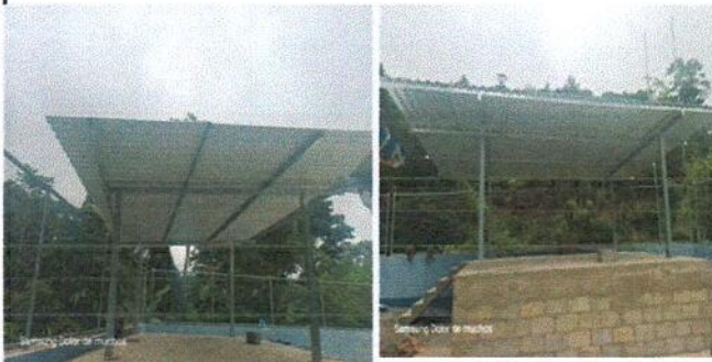
Foto1: Sustitucion de lamina por lamina troquejada, sustitucion de estructura de madera por metal, cambio de piso de madera por terraza de concreto
