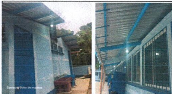
Foto 7: reparacion de sistema electrico ( sustitucion de focos ahorradores)
