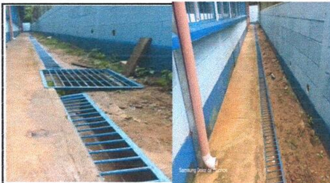
Foto 3: instalacion de regillas de barrila de 1/2 sobre canal de concreto
