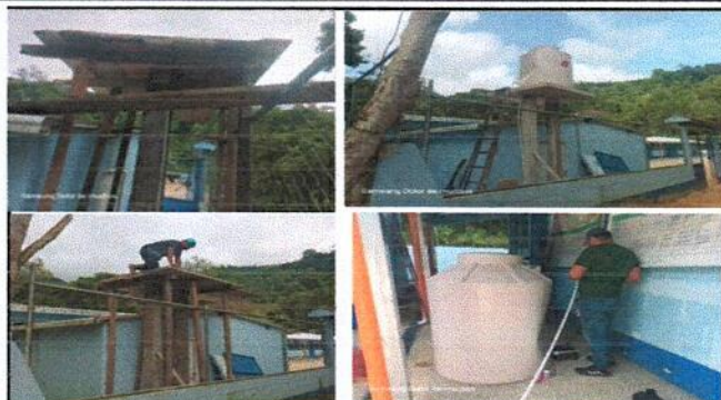
Foto 8: instalacion de columna de concreto, para psotener base de concreto, para tinaco en cocina y Accesorios para tinaco.
