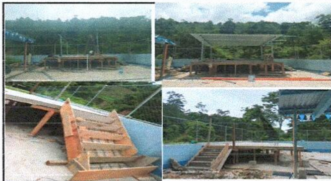
Foto1: Sustitucion de lamina por lamina troquelada, sustitucion de estructura de madera por metal, cambio de piso de madera por terraza de concreto
