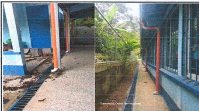
Foto 2: instalacion de tubo metalico y bajadas de agua pluvial.
