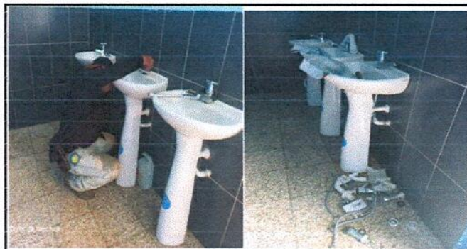
Foto 5: sustitucion de accesorios de lavamanos y fijar la base sobre el piso.
