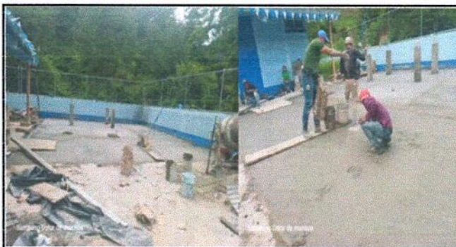
Foto 6: mejoramiento a patio de tierra.
