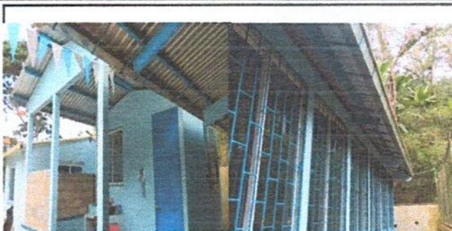
Foto 2: instalacion de tubo metalico y bajadas de agua pluvial.
