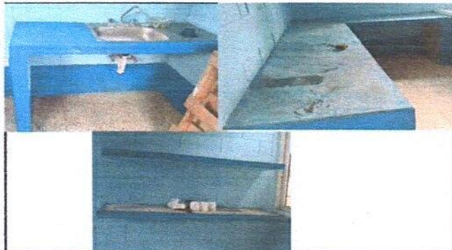
Foto 9: instalacion de azulejo en lavatrastos y muebles de cocina
