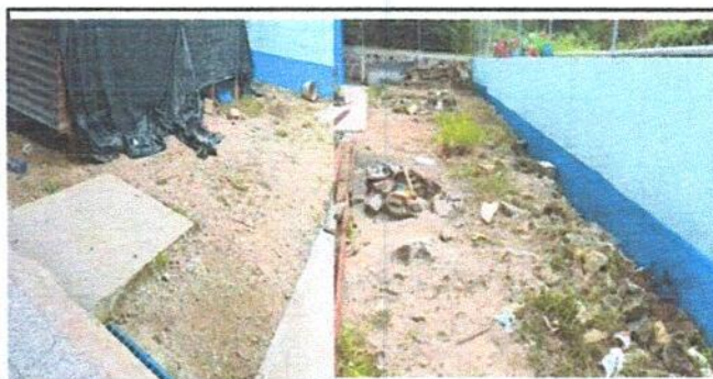
Foto 6: mejoramiento a patio de tierra.
