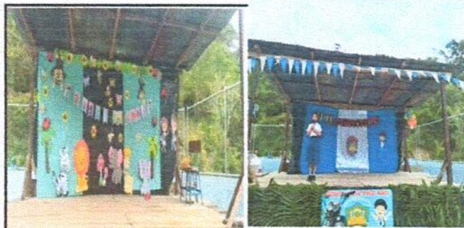
foto 11 Cambio de piso de madera por terraza de concreto a escenario, y columna con zapata y corona para soporte de teraza del escenario.
