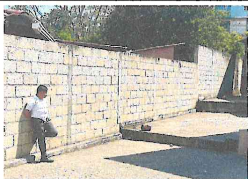
Foto 7: Pintura en muro parte interior
