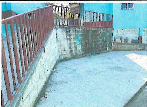
Foto 13: Colocación de piso cerámico atrás de las aulas parte lateral
