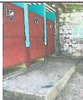
Foto 11: Sustitución de torta de cemento por piso ceramico afuera de los baños
