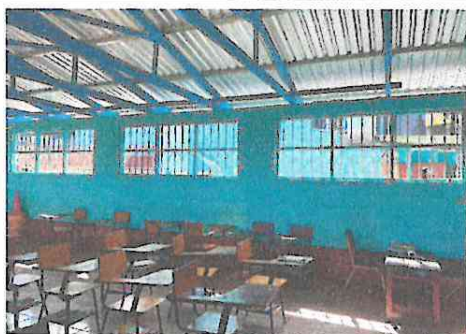
Foto1: Instalación de ventanas de PVC aula 1
