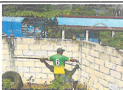
Foto 6: Repello y cernido parate interior del muro
