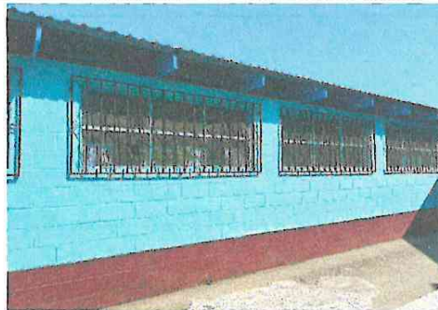
Foto 2: Instalación de ventanas de PVC aula 2
