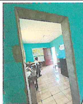
Foto 4: Colocación de puerta de PVC (vidrio)
