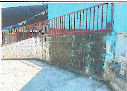
Foto 5: Reparación y pintura de baranda
