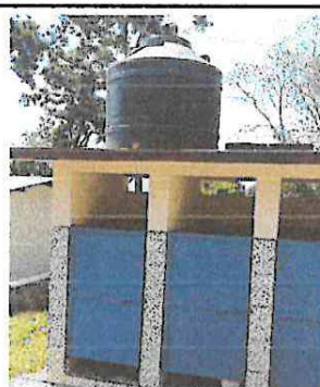
Foto 10: Sustitución de Tinaco de 1,100 litros por Tinaco y suministros de 1,100 litros
