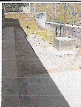
Foto 9: mejoramiento de patio: preparar y fundir torta de cemento
