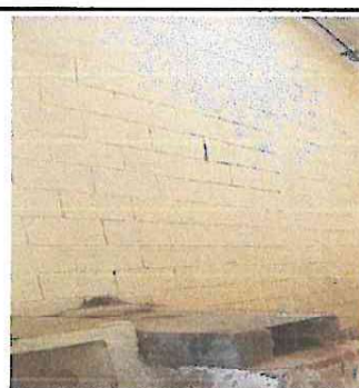
Foto 6: Instalar ventana de metal en cocina
