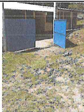
Foto 8: rampa de acceso, preparar y fundir torta de concreto
