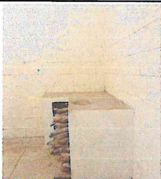
Foto 7: Instalar azulejos en paredes de cocina
