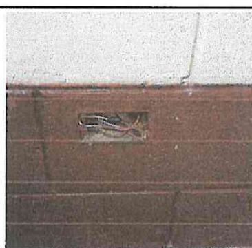
Foto 4: Instalación de electricidad en cocina y aula módulo 1
