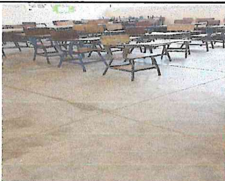
Foto 1: Sustitución de piso, por piso cerámico con zócalo aula módulo 1.
