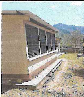
Foto 11: pintura general en baño, cocina y aulas
