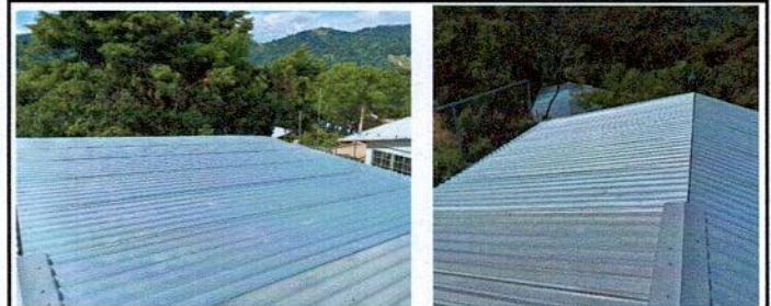
SUSTITUCION DE LAMINA EN MAL ESTADO POR LAMINA TROQUELADA ALUZINC CALIBRE 26
