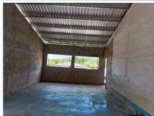
SUSTITUCION DE PISO DE TIERRA POR PISO DE CONCRETO
