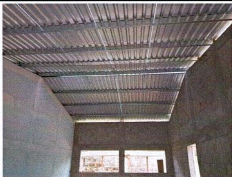
SUSTITUCION DE ESTRUCTURA DE SOPORTE DE MADERA POR METAL
