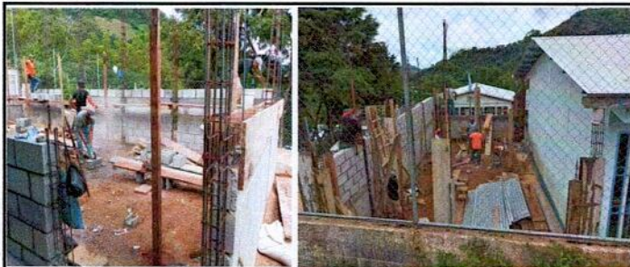
PAREDES DE BLOCK Y COLUMNAS DE CONCRETO
