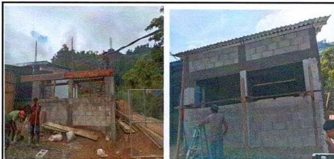
FABRICACION E INSTALACION DE VENTANAS DE PVC
