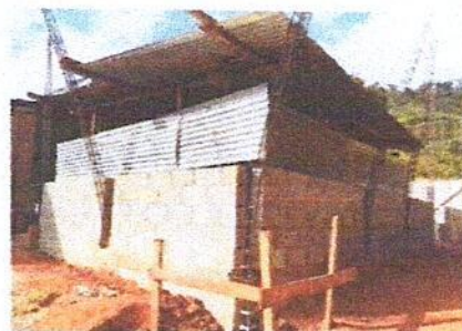
Foto 6: Sustitución de piso de tierra por piso de concreto
