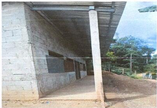
FOTO: Mejoramiento con repello en muros exteriores e interiores.
