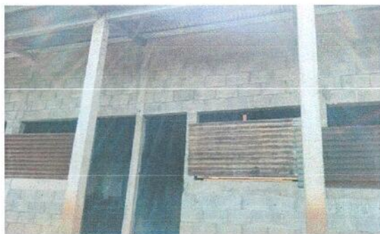
FOTO 3: Instalacion de ventanas corredizas de PVC y balcones de metal.
