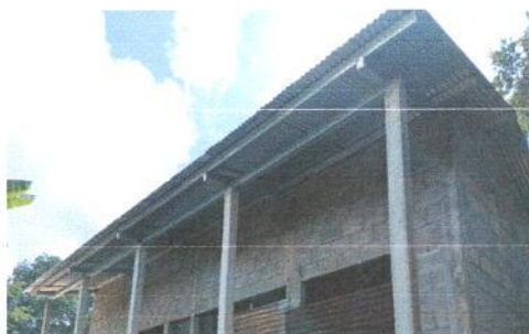
FOTO 6: Instalacion de canales de metal para aguas pluviales y pescantes para sostener canales.
