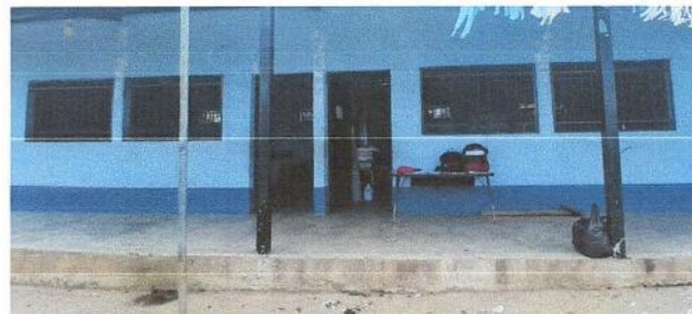
FOTO 8: Instalacion de ventanas PVC corredizas.
