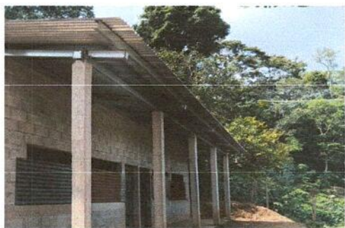
FOTO 7: Instalacion de bajadas para aguas pluviales PVC.
