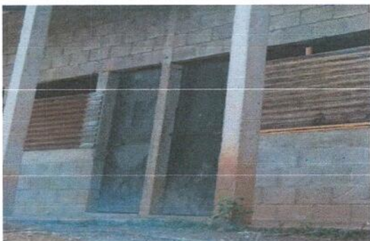
FOTO 5: Instalacion de puerta de metal por puerta de metal.
