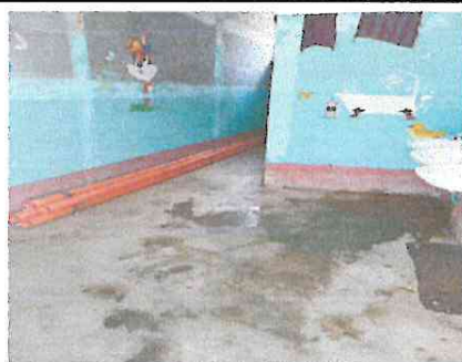
Foto 5: cambio de piso en los baños de hombres y mujeres
