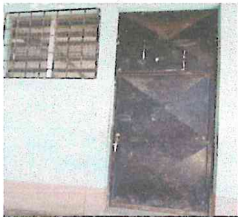
Foto 3: pintura de puertas, lijado,cambio de tubo
