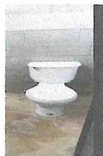
Foto 4: cambio de accesorios de baños de mujeres y varones
