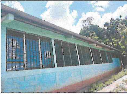
Foto1: Pintura de muros exteriores
