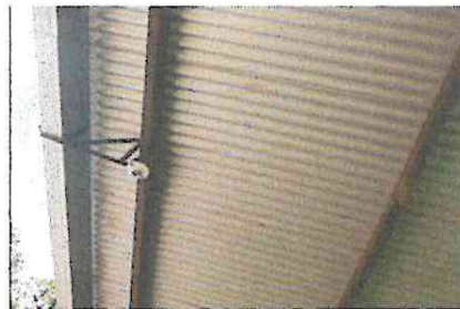
Foto 4: Sustitucion de plafoneras y lámparas
