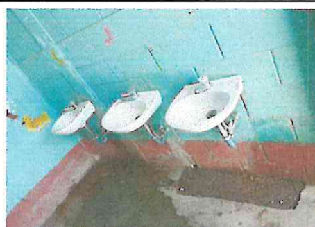
Foto 6: sustitución de accesorios de lavamanos
