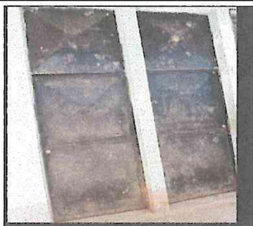
Foto 3: pintura, lijado. Cambio de tubo puertas de baño
