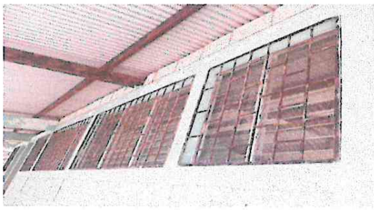
Foto 5: Mantenimiento a balcones de metal
