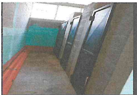
Foto 1: Pintura de muros exteriores baños
