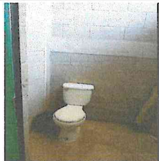
Foto 2: pintura de muros interiores de baños
