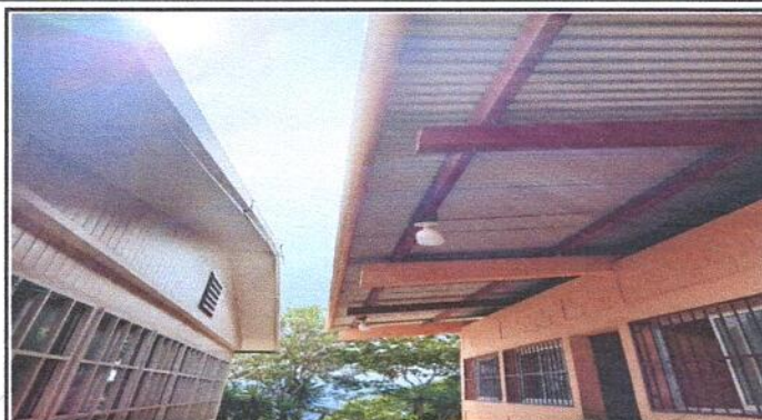
Foto 2: Instalación de bajada de agua pruvial, canal de pvc, y tubo de pvc.
