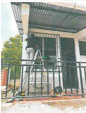
Foto 3: Suministro e Instalación de balcon de metal.
