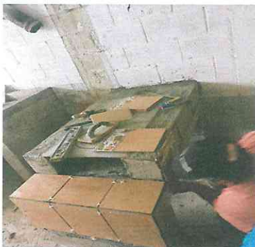
Foto 5: Sustitución e instalacion de estufa rural (completa) Base, chimenea, plancha de metal y azulejo
