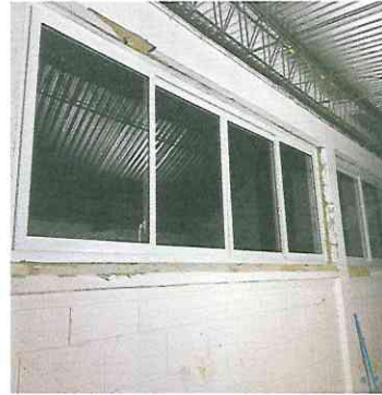
Foto 2: Sustitución de ventana en mal estado por ventana de PVC
