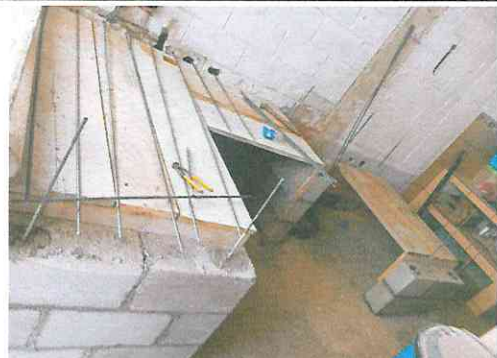
Foto 6: Suministro e instalación de tablón de cemento ancho 0.90mts de alto * 3.80 mts de de largo * 0.80 de mts de ancho
