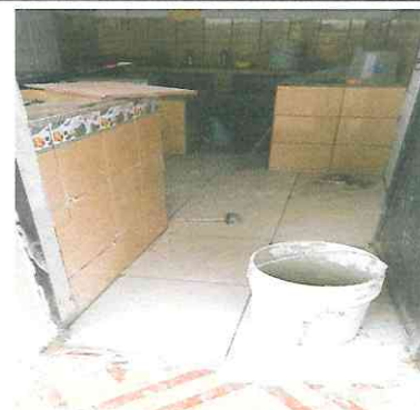
Foto 4: Sustitución de piso de cemento por piso ceramico
