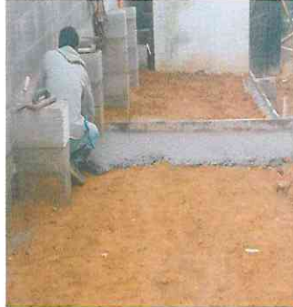
Foto1: Sustitución de piso de tierra por torta de cemento
