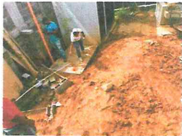
Foto1: Sustitución de piso de tierra por torta de cemento
