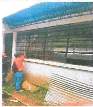
Foto 2: Sustitución de ventana en mal estado por ventana de PVC
