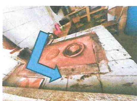
Foto 6: Suministro e instalación de tablero de cemento ancho 0.90mts de alto * 3.80 mts de largo * 0.80 de mts de ancho
