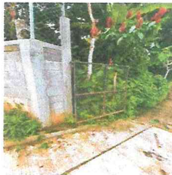
Foto 8: Sustitución e Instalación de porton en mal estado por porton de metal tubo, chapa 16 y lamina getima 1.5 de 2 mts de alto * 3.40 mts de largo
