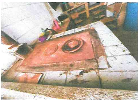
Foto 5: Sustitución e instalación de estufa rural (completa) Base, chimenea, plancha de metal y azulejo
