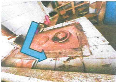
Foto 7: Suministro e Instalación de azulejo en tablon de cemento
