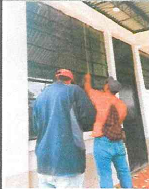
Foto 2: Sustitución de ventana en mal estado por ventana de PVC
