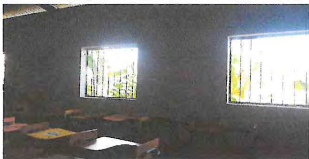
Foto 1.3: Instalación de ventanas de pvc
