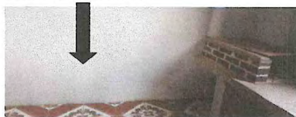
Instalación de azulejo en plancha de concreto.
