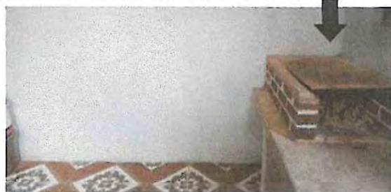
Foto 3.4 Instalación de plancha de metal en plancha de concreto ya existente en cocina.
