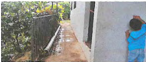
Foto 1.5 Instalación de piso antideslizante enfrente de aula
