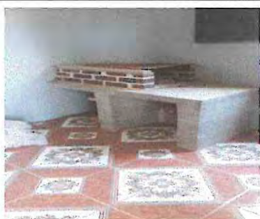
Foto 3.3 Instalacion de azulejo en plancha de concreto existente en cocina
