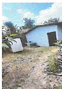
Foto 1.4 Sustitución de piso de tierra por entortado de cemento al lado de aula
