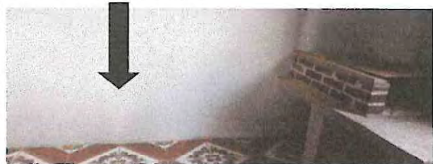
Fundición de plancha de concreto en cocina.
