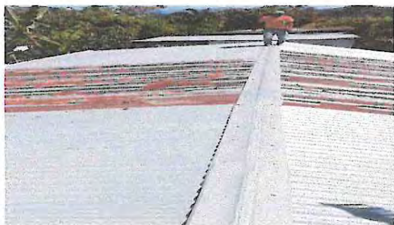
Foto 1.1: Sustitución de lamina a lamina troquelada aluzinc calibre 26
