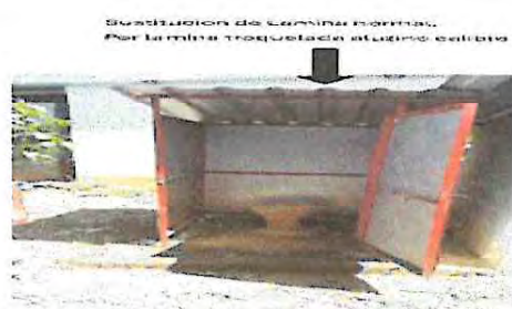
Foto 2.5 Sustitución de lámina normal por lámina troquelada aluzinc calibre 26
