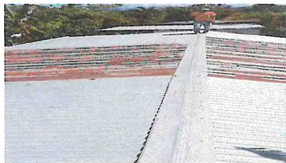
Foto 1.2: Sustitución de capotes de metal
