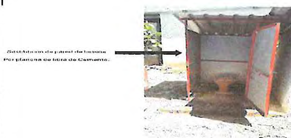
Foto 2.4 Sustitución de pared de lámina por plancha de fibra de cemento
