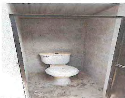
Foto 2.3 Sustitución de inodoro normal por baby toilet
