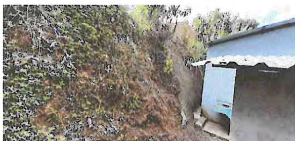
4.1 Reparación de talud natural con malla y repello
