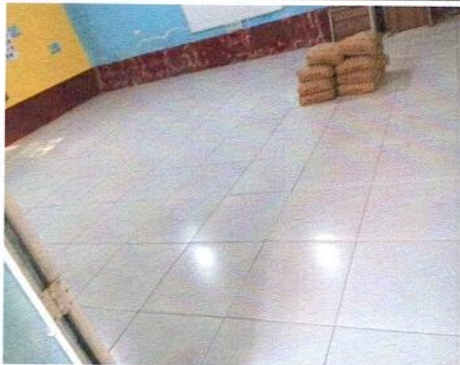
3.2 SUSTITUCION DE PISO DE CEMENTO POR PISO CERAMICO
