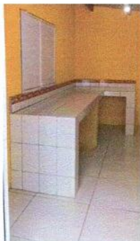
4.4 SUMINISTRO E INSTALACION DE DE AZULEJO EN PLANCHA YA EXISTENTE
