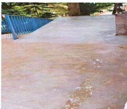
4.6 SUSTITUCION DE PISO DE TIERRA POR ENTORTADO DE CEMENTO FRENTE A COCINA
