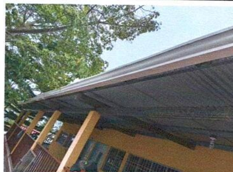
2.2 SUMINISTRO E INSTALACION DE CANAL DE PVC EN CORREDOR
