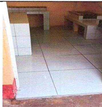
4.5 SUSTITUCION DE PISO DE CEMENTO POR PISO CERAMICO EN COCINA
