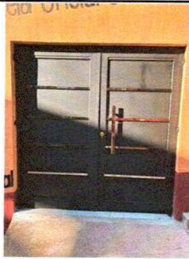
2.3 SUSTITUCION DE PORTON EN MAL ESTADO POR PORTON DE TUBO DE HIERRO GALVANIZADO PERFIL 4X2 Y LAMINA GALVANIZADA CALIBRE 24
