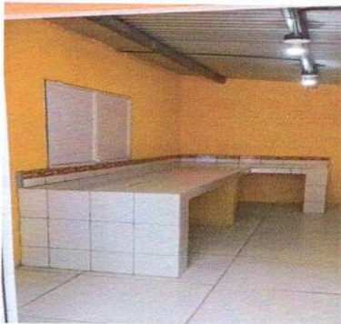
4.2 SUMINISTRO E INSTALACION DE TABLON DE CEMENTO 0.90 ALT. X 3.90 MTS DE LARGO X 0.60 DE ANCHO
