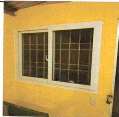
4.1 SUSTITUCION DE VENTANA DE CELOSIA POR VENTANA DE PVC
