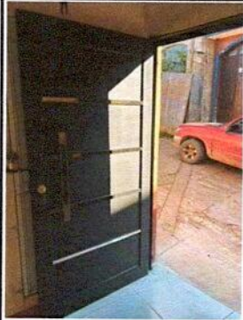
2.3 SUSTITUCION DE PORTON EN MAL ESTADO POR PORTON DE TUBO DE HIERRO GALVANIZADO PERFIL 4X2 Y LAMINA GALVANIZADA CALIBRE 24
