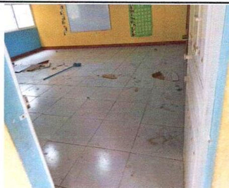
5.1 SUSTITUCION DE PISO DE CEMENTO POR PISO CERAMICO
