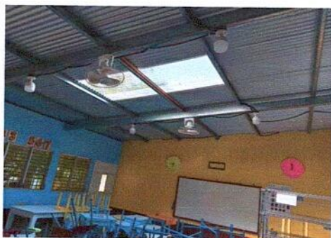
1.3 SUSTITUCION DE LAMINA POR LAMINA TRASLÚCIDA
