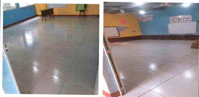
1.4 SUSTITUCION DE PISO DE CEMENTO POR PISO CERAMICO
