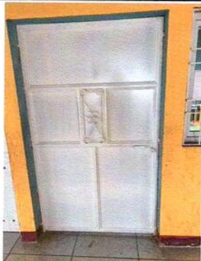
1.1 SUSTITUCION DE PUERTA EN MAL ESTADO POR PUERTA DE METAL 206 CM DE ALTO X 118 CM DE ANCHO
