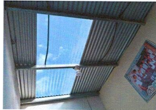
3.1 SUSTITUCION DE LAMINA POR LAMINA TRASLÚCIDA
