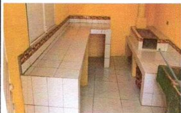
4.4 SUMINISTRO E INSTALACION DE DE AZULEJO EN PLANCHA YA EXISTENTE
