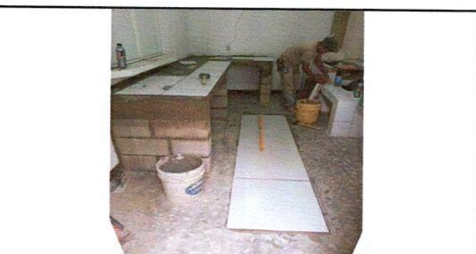
4.3 SUMINISTRO E INSTALACION DE AZULEJO EN TABLON DE CEMENTO
