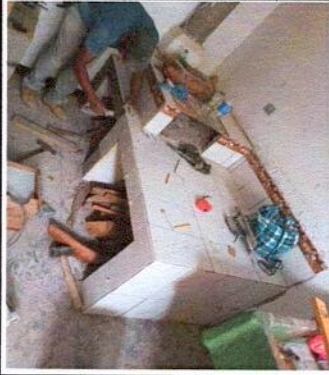
4.4 SUMINISTRO E INSTALACION DE DE AZULEJO EN PLANCHA YA EXISTENTE
