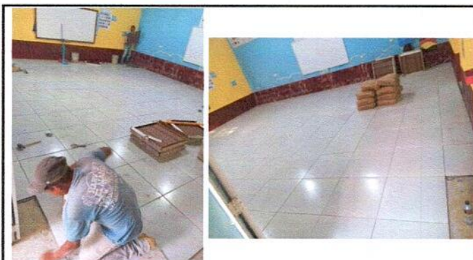
1.4 SUSTITUCION DE PISO DE CEMENTO POR PISO CERAMICO
