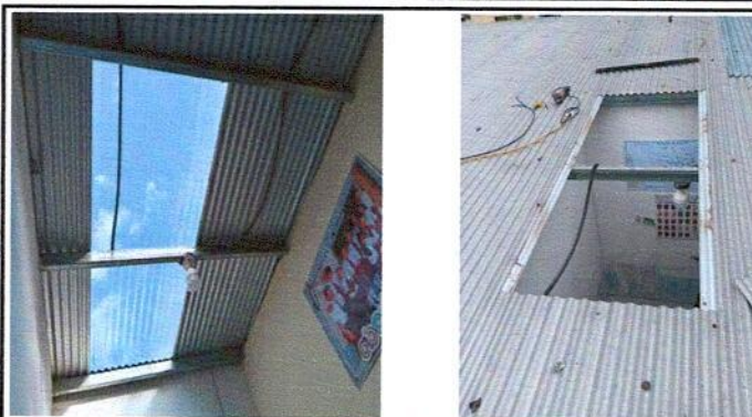
3.1 SUSTITUCION DE LAMINA POR LAMINA TRASLÚCIDA
