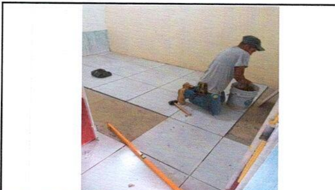
3.2 SUSTITUCION DE PISO DE CEMENTO POR PISO CERAMICO
