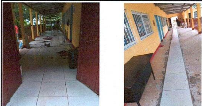
2.1 SUSTITUCION DE PISO DE CEMENTO POR PISO CERAMICO FRENTE A AULAS
