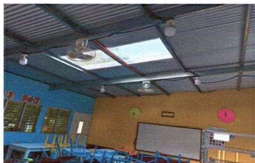
1.3 SUSTITUCION DE LAMINA POR LAMINA TRASLÚCIDA
