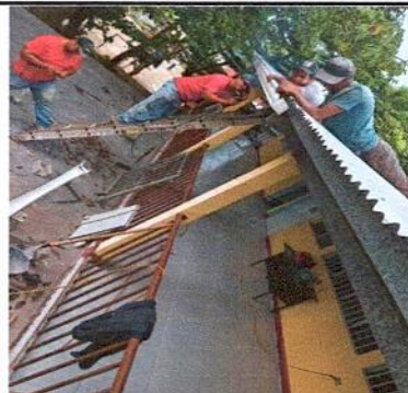
2.2 SUMINISTRO E INSTALACION DE CANAL DE PVC EN CORREDOR
