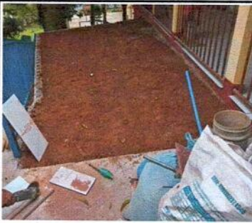
4.6 SUSTITUCION DE PISO DE TIERRA POR ENTORTADO DE CEMENTO FRENTE A COCINA
