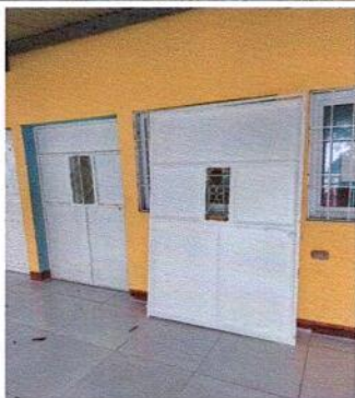
1.1 SUSTITUCION DE PUERTA EN MAL ESTADO POR PUERTA DE METAL 206 CM DE ALTO X 118 CM DE ANCHO
