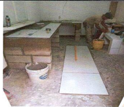
4.5 SUSTITUCION DE PISO DE CEMENTO POR PISO CERAMICO EN COCINA
