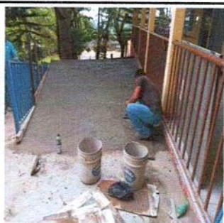
4.6 SUSTITUCION DE PISO DE TIERRA POR ENTORTADO DE CEMENTO FRENTE A COCINA
