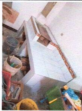
4.4 SUMINISTRO E INSTALACION DE DE AZULEJO EN PLANCHA YA EXISTENTE
