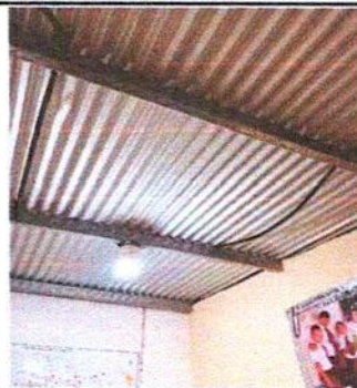
3.1 SUSTITUCION DE LAMINA POR LAMINA TRASLÚCIDA
