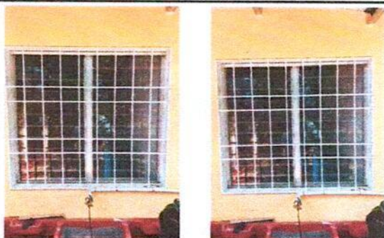
4.1 SUSTITUCION DE VENTANA DE CELOSIA POR VENTANA DE PVC
