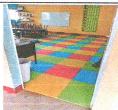
5.1 SUSTITUCION DE PISO DE CEMENTO POR PISO CERAMICO
