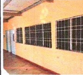
1.2 SUSTITUCION DE VENTANA DE CELOSIA POR VENTANA DE PVC
