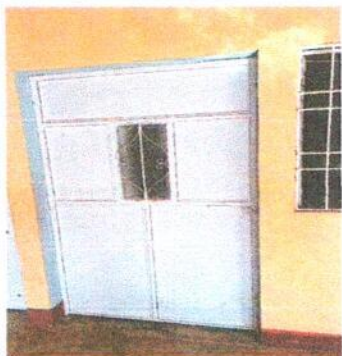
1.1 SUSTITUCION DE PUERTA EN MAL ESTADO POR PUERTA DE METAL 206 CM DE ALTO X 118 CM DE ANCHO
