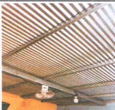
1.3 SUSTITUCION DE LAMINA POR LAMINA TRASLÚCIDA
