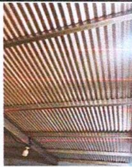
1.3 SUSTITUCION DE LAMINA POR LAMINA TRASLÚCIDA
