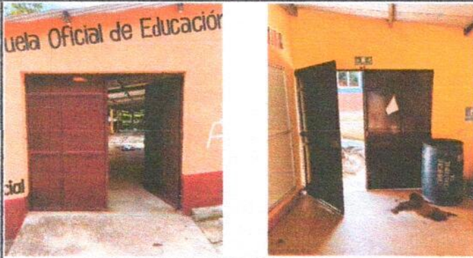
2.3 SUSTITUCION DE PORTON EN MAL ESTADO POR PORTON DE TUBO DE HIERRO GALVANIZADO PERFIL 4X2 Y LAMINA GALVANIZADA CALIBRE 24
