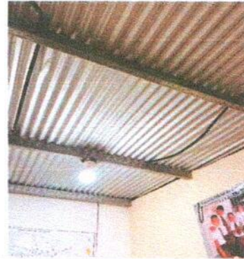
3.1 SUSTITUCION DE LAMINA POR LAMINA TRASLÚCIDA
