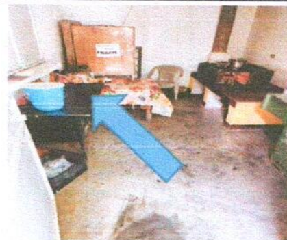
4.3 SUMINISTRO E INSTALACION DE AZULEJO EN TABLON DE CEMENTO
