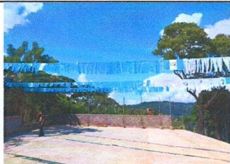
Foto 1: CUBIERTA DE TORTA DE CEMENTO
