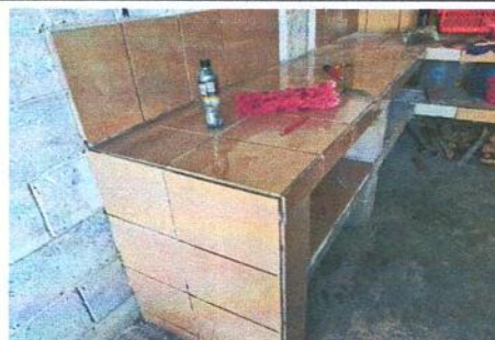
Foto 6: ELABORACIÓN DE GABINETE E INSTALACIÓN DE AZULEJO
