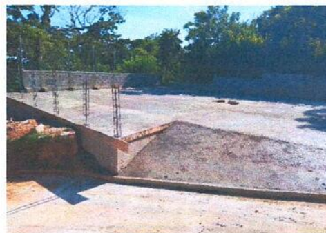
Foto 2: CUBIERTA DE TORTA DE CEMENTO
