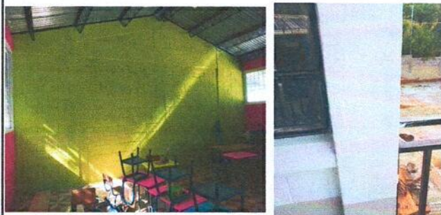
Foto 3: APLICACIÓN DE PINTURA EN PAREDES
