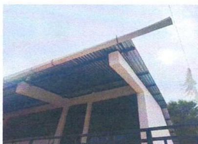
Foto 5: INSTALACIÓN Y BAJADA DE AGUA
