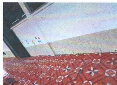
Foto 4: INSTALACIÓN DE PISO EN CORREDOR
