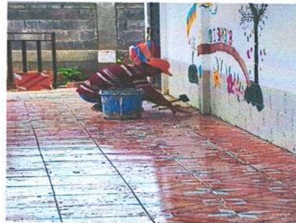
Foto 4: INSTALACIÓN DE PISO EN CORREDOR
