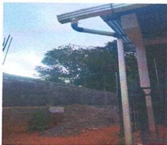
Foto 5: INSTALACIÓN Y BAJADA DE AGUA
