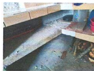
Foto 6: ELABORACIÓN DE GABINETE E INSTALACIÓN DE AZULEJO
