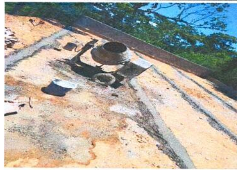
Foto 2: CUBIERTA DE TORTA DE CEMENTO
