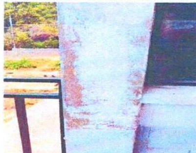
Foto 4: PINTURA EN PAREDES
