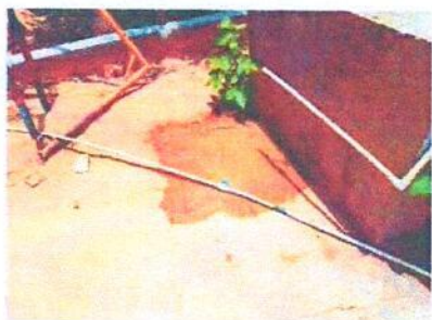
Foto 5: INSTALACION DE FOSA
