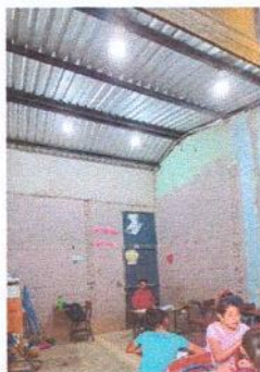
Foto 3: Reparación de muro interno de block entre cocina y aula de clases con estructura de madera y cerramientos de tabla yeso.
