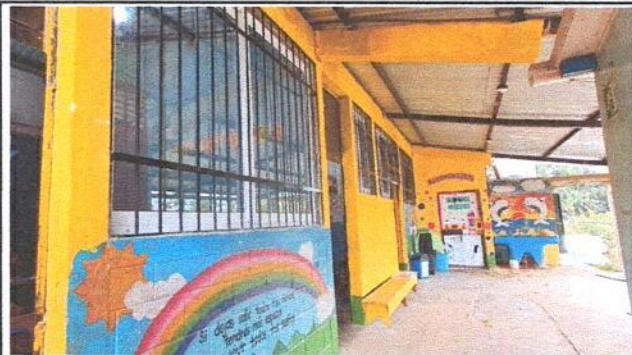
Foto 2: instalación de balcones de metal
