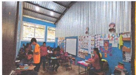
Foto 4: Se reparará el sistema eléctrico de todo el establecimiento para la iluminación y buen ambiente para los alumnos
