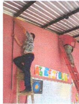
Foto 4: Se reparará el sistema eléctrico de todo el establecimiento para la iluminación y buen ambiente para los alumnos
