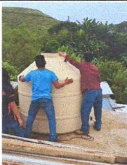
Foto 5: Reparación y mantenimiento de cisternas / depósito de agua.
