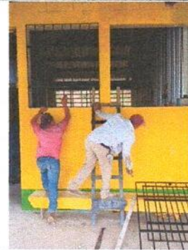
Foto 2: instalación de balcones de metal
