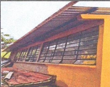
Foto 1: Las ventanas se sustituirán a ventana de PVC corrediza
