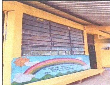
Foto 2: Instalación de balcones de metal
