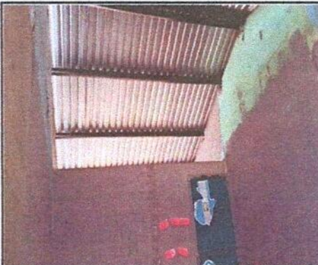
Foto 3: Reparación de muro interno de block entre cocina y aula de clases con estructura de madera y cerramientos de tabla yeso.
