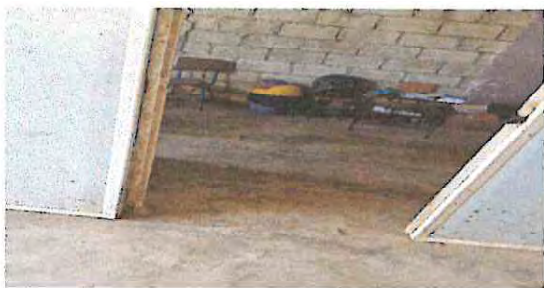
Foto 2.1 Sustitución de piso de cemento a ceramico en cocina
