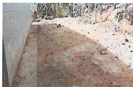
Foto 4.1 Sustitución de patio de tierra por patio de cemento
