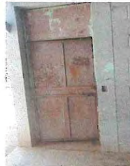
Foto 1.4 Sustrución de puerta de metal por puerta de metal
