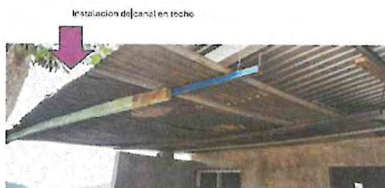
5.2 Instalacion de canal en techo
