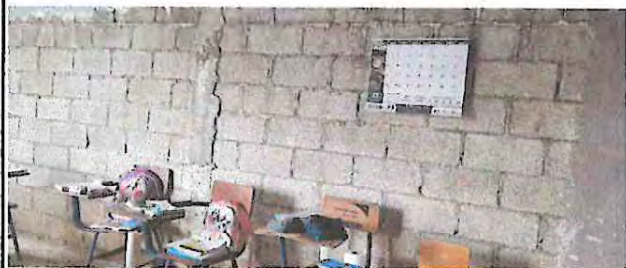
Foto 2.3 Aplicación de repello a paredes
