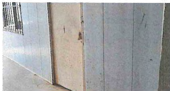
Foto 2.2 Sustitución de puerta de metal por puerta de metal 2.05 mts de alto por 0.90 mts ancho
