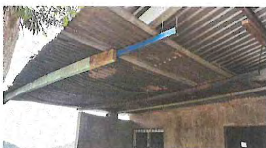
Foto 5.1 Sustitucion de lamina a lamina troquelada alucin calibre 26
