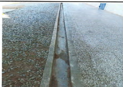
3 PATIO FOTO 3.1 MEJORAMIENTO DE CUNETA CON REJILLA DE HIERRO DE 1/2 PULGADA, DE 16 MTS DE LARGO POR 35CM DE ANCHO
