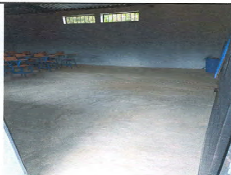
2 AULA 3 FOTO: 2.1 SUSTITUCIÓN DE PISO LISO DE CONCRETO POR PISO CERÁMICO
