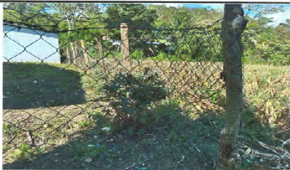
1 CIRCULACIÓN PERIMETRAL FOTO 1.1 SUSTITUCIÓN DE CERCADO DE POSTES DE MADERA TELA METÁLICA Y ALAMBRE DE PUAS POR CERCADO DE TUBO GALVANIZADO HG Y TELA MALLA
