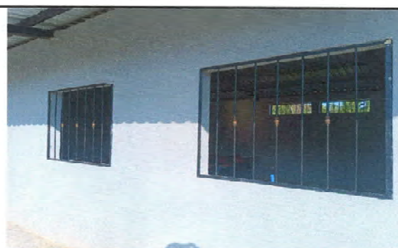
AULA 3 Foto 2.2 INSTALACIÓN DE VENTANAS CORREDIZAS DE PVC 1.20X1.00
