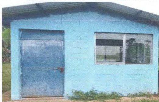
Foto1: AREA DE COCINA PARA REMOZAMIENTO, SUSTITUCION DE VENTANAS, INSTALACION DE BALCONES.
