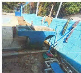
Foto 1: Sustrucción de pila, estructura metálica y techo de lamina troquelada, marca aluzinc.
