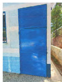
Foto 2: sustitución de chapa de puerta
