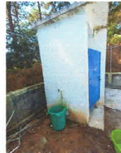
Foto 6: SANITARIOS: Sustitución de lavamanos
