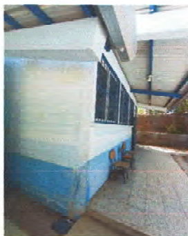
Foto 1: AULAS: Pintura en EXTERIOR E INTERIOR
