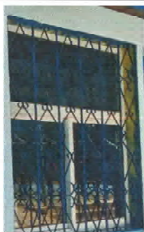
Foto 3: lijado, cepillado y aplicación de pintura a balcones.
