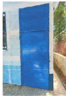
Foto 2: lijado, cepillado y aplicación de pintura de puertas
