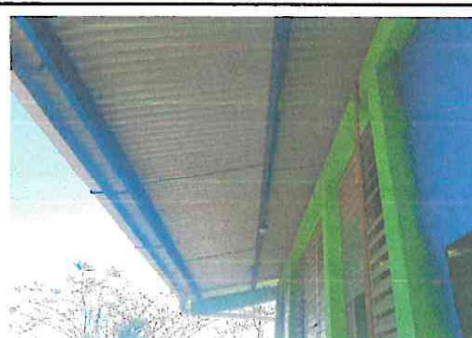
Foto 4: Reparación de cableado electrico
