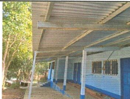
Foto 4: Tubos metalicos para soporte del techo
