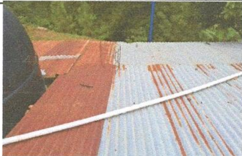
Foto1: Sustrución de lámina, por lámina troquelada aluzinc calibre 26
