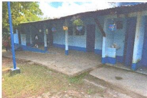
Foto 4: Sustrución de estructura de soporte de metal, por metal
