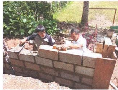
foto 4: Levantado de paresdes de block
