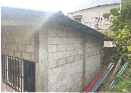
Foto 1: Sustrucción de lámina, por lamina troquilada aluzinc calibre 26
