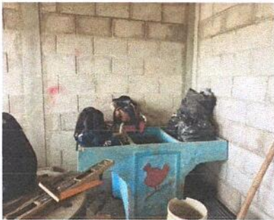
FOTO 9: Sustitución de pila de cemento de un lavadero largo: 1m, ancho: 0.60 y Alto 0.90
