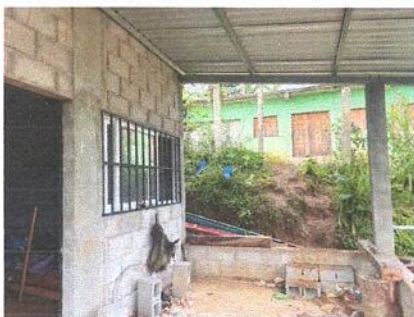
Foto 3: Colocacion de sistema electrico fuerza y iluminacion
