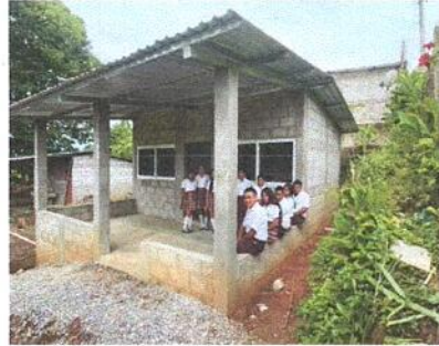
FOTO 8: Sustitucion de canal de metal mas estructura de soporte
