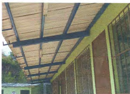
Foto 1: Sustitución de soporte o pescante de metal para canal ya que se encuentran doblados y oxidados , sustitución de canal de metal, reparación de bajada de agua pluvial, tubo PVC 3", sustitución plafoneras y sustitución de lamparas LED.
