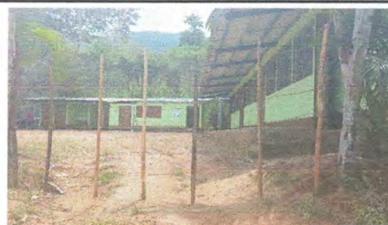
Foto 4: Fabricación de bases concreto para colocación de porton metalico 3mts alto, Ancho 25x25, fabricación de estructura de metal de techo de porton de ingreso, colocación de lamina troquelada aluzinc calibre 26, fabricación e instalación de porton metalico de ingreso y fundición de planchas de concreto en ingreso a escuela.
