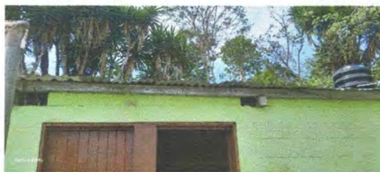
Foto 2: Mantenimiento a estructura de soporte de metal, sustitución de lamina por, lamina troquelada aluzinc calibre 26, sustitución de elementos de fijación.
