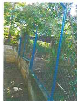
Foto 6: Sustitución de Malla Galvanizada en Muro Perimetral
