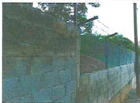
Foto 5: Instalación de Muros de Block (Se Instalarán Columnas y Vigas) en Muro Perimetral
