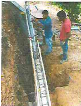
Foto 5: Instalación de Muros de Block (Se Instalarán Columnas y Vigas) en Muro Perimetral
