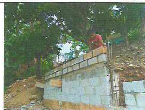
Foto 4: Instalación de Muros de Block (Se Instalarán Columnas y Vigas) en Muro Perimetral
