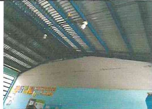
Foto 2: Instalación de Tabla Yeso en cierre de Aulas
