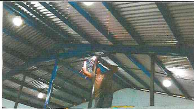
Foto 3: Instalación de Cielo Falso en Aulas
