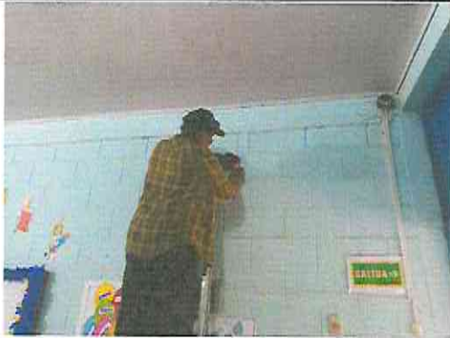
Foto 1: Instalación de Tabla Yeso en cierre de Aulas
