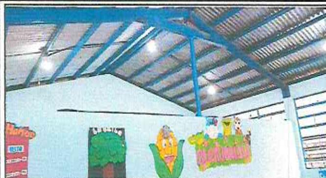
Foto1: Instalación de Tabla Yeso en cielle de Aulas
