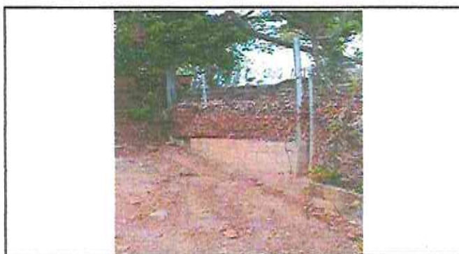
Foto 4: Instalación de Muros de Block ( Se Instalarán Columnas y Vigas) en Muro Perimetral
