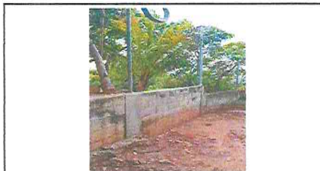
Foto 6: Sustitución de Maya Galvanizada en Muro Perimetral
