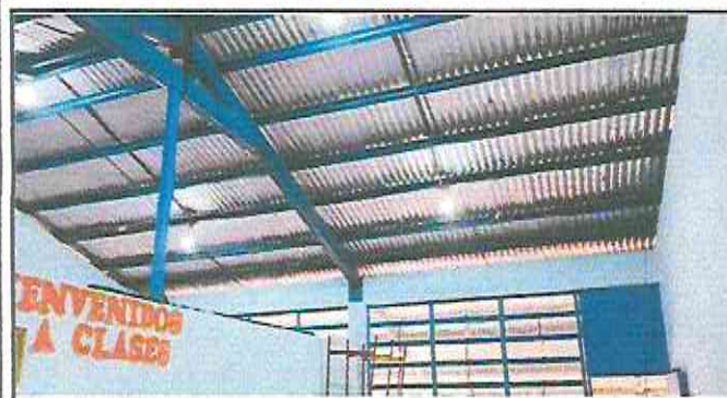
Foto 3: Instalación de Cielo Falso en Aulas
