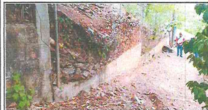
Foto 5: Instalación de Muros de Block ( Se Instalarán Columnas y Vigas) en Muro Perimetral
