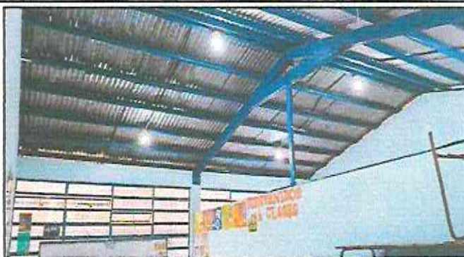
Foto 2: Instalación de Tabla Yeso en cielle de Aulas
