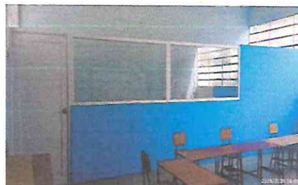
Foto 8: Cerramiento de dirección y bodega (doble cara), puerta PVC y ventana PVC
