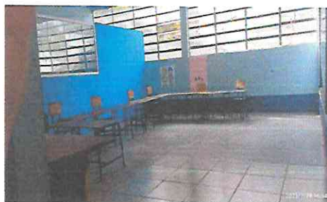
Foto 10: Reparación de torta de concreto y sustitución de piso cerámico
