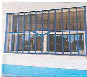
Foto 11: sustitución de venanas por ventanas PVC
