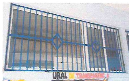
Foto 12: Sustitución de ventanas por ventanas PVC y sustitución de Balcones
