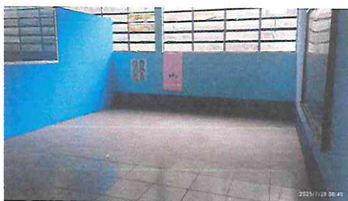
Foto 9: Reparación de torta de concreto y sustitución de piso cerámico
