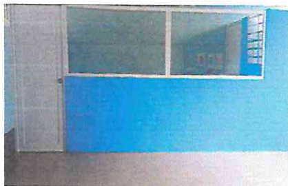
Foto 7: Retiro de tabique de madera en dirección
