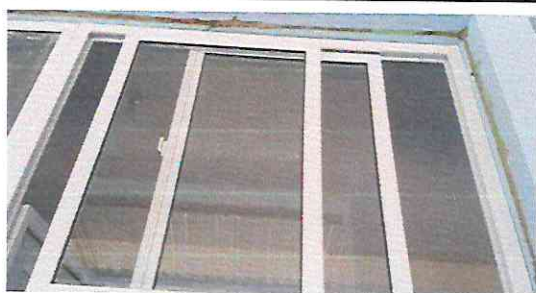
Foto 11: sustitución de venanas por ventanas PVC
