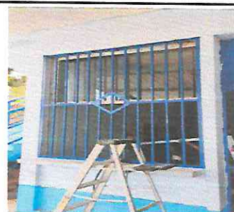
Foto 12: Sustitución de ventanas por ventanas PVC y sustitución de Balcones
