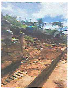
Foto1: Reparación de talud con muro de contención
