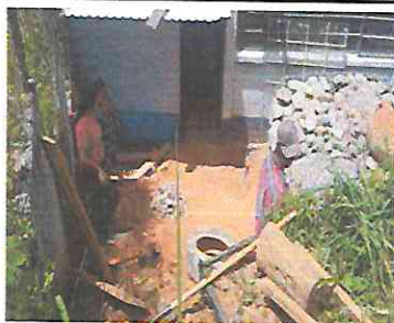
Foto 5: Reparación de gradas de madera por gradas de concreto
