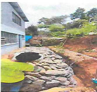
Foto 3: Reparación de muro de contención, con gaviones y muro ecológico
