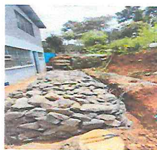
Foto 4: Reparación de muro de contención con caja gaviones y muro ecológico
