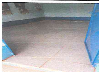
Foto 10: Reparación de torta de concreto y sustitución de piso cerámico
