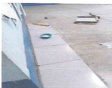
Foto 9: Reparación de torta de concreto y sustitución de piso cerámico
