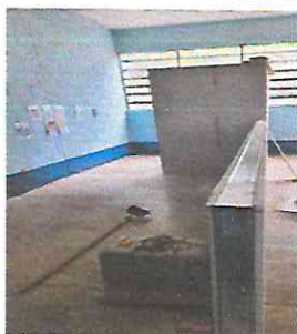
Foto 7: Retiro de tabique de madera en dirección
