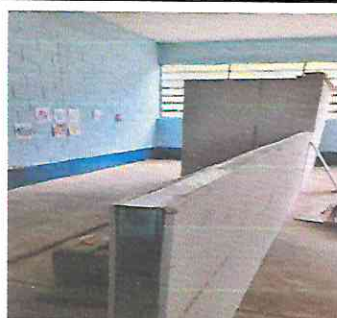
Foto 8: Cerramiento de dirección y bodega (doble cara), puerta PVC y ventana PVC
