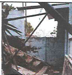
Foto 5: Reparación de Gradas de Madera por Gradas de Concreto.
