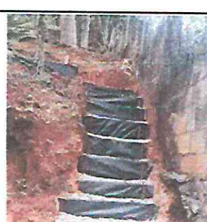
Foto 6: Reparación de Gradas de Madera por Gradas de Concreto.
