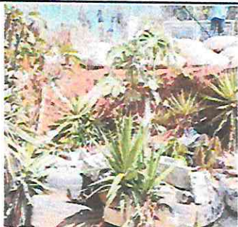
Foto 1: Reparación de Talud con Muro de Contención.
