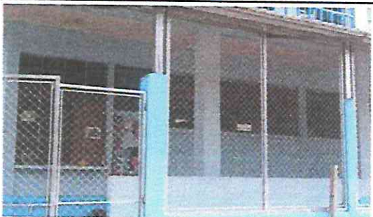
Foto 11: Sustitución de Ventanas por Ventanas de PVC.
