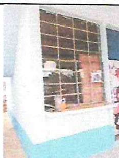
Foto 12: Sustitución de Ventana por Ventana PVC y Sustitución de Balcones.
