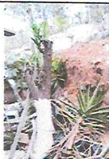
Foto 3: Reparación de Muro de Contención, con Gaviones y Muro Ecológico.
