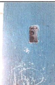
Foto 4: Sustitución de tomacorrientes
