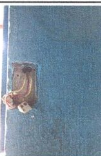
Foto 5: Sustitución de apagadores
