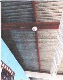
Foto 11: Sustrucción de plafoneras, cajas exagonales y bombillas tipo led recargble
