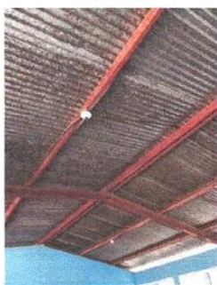
Foto 3: Sustitución de plafoneras, cajas exagonales
