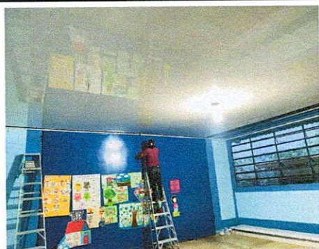
Foto 3: Instalación de cielo falso en aulas (incluye trabajos eléctricos)
