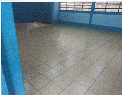
Foto 1: Sustitución de piso de concreto para piso de concreto por piso cerámico Mate en aulas.
