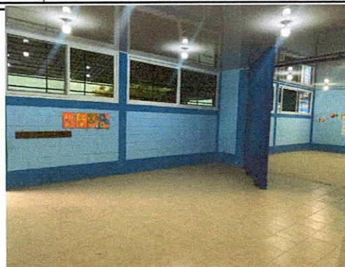
Foto 2: Sustitución de piso de concreto por piso cerámico Mate en aulas.
