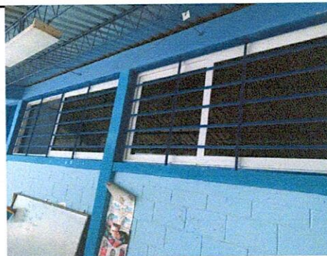
Foto 6: Instalación de ventanas de pvc en aulas.
