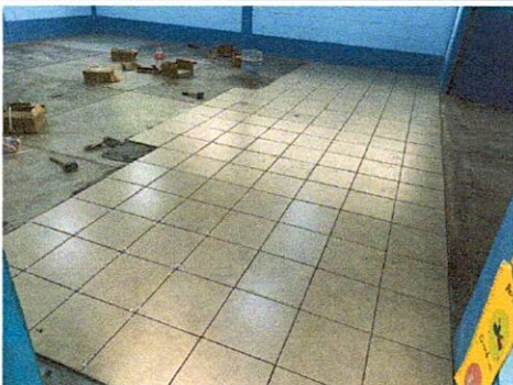
Foto 1: Sustitución de piso de concreto para piso de concreto por piso cerámico Mate en aulas.
