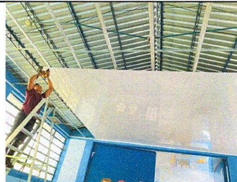
Foto 4: Instalación de cielo falso de pvc en aulas.
