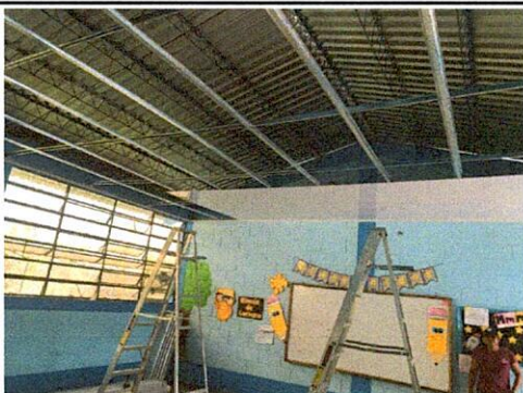
Foto 3: Instalación de cielo falso en aulas (incluye trabajos eléctricos)
