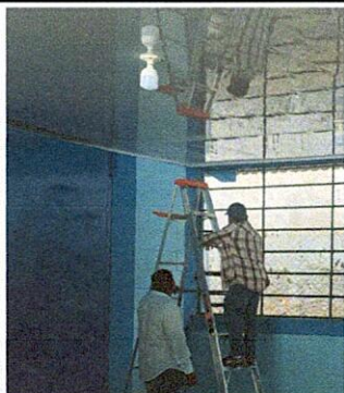
Foto 5: Instalación de iluminaria empotrada al cielo falso tipo led
