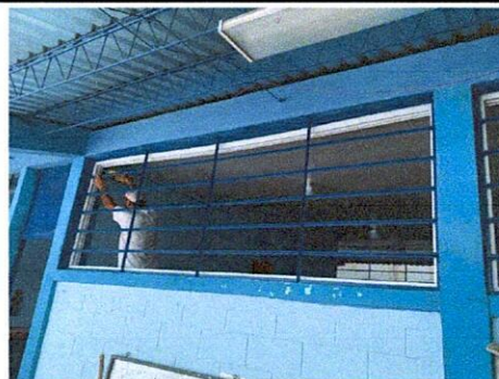
Foto 6: Instalación de ventanas de pvc en aulas.
