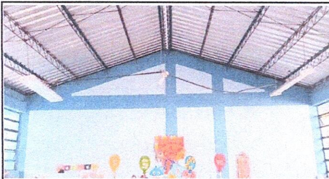
Foto 3: Instalación de Cielo Falso en Aulas (Incluye trabajos eléctricos).
