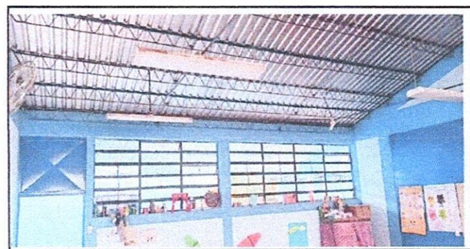
Foto 6: Instalació de Ventanas PVC en Aulas
