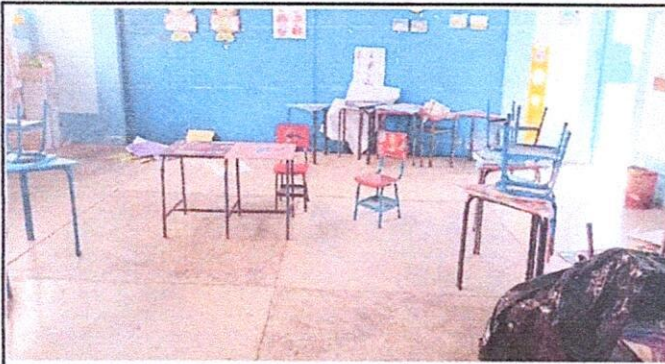
Foto 1: Sustitución de Piso de Concreto por Piso Cerámico Mate en Aulas
