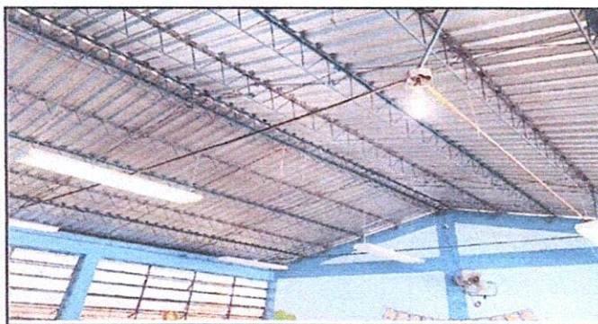
Foto 5: Instalación de iluminaria empotrada al cielo falso tipo led.
