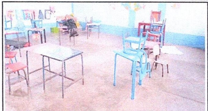
Foto 2: Sustitución de Piso de Concreto por Piso Cerámico Mate en Aulas
