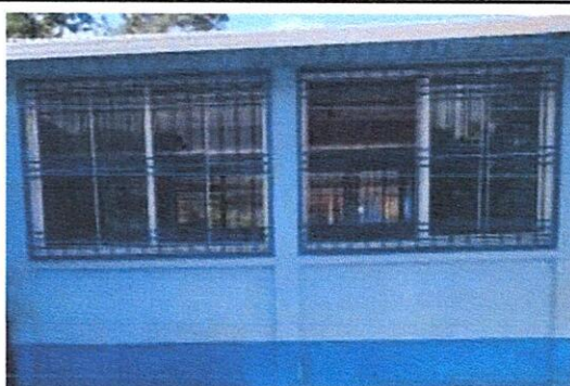
Foto 4: Pintura en Muros Interiores y Exteriores
