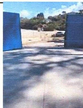
Foto 6: Sustitución de Cuneta de Concreto en Patio
