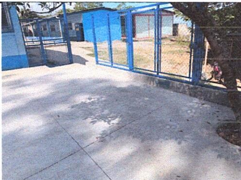
Foto 7: Instalación de Malla y Tubo Proceso en Patio. Esta intervención busca cerrar el área del patio, mejorando la seguridad y delimitación del espacio escolar.
