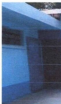
Foto 3: Pintura en Muros Interiores y Exteriores
