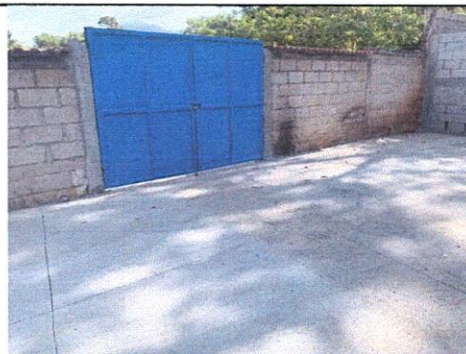
Foto 10: Instalación de Portón de Metal de 2.90 mts de Ancho por 2.30 de Alto. Despues de la demolición se piensa instalar el porton antes mencionado para que los educandos tengan su propia entrada.
