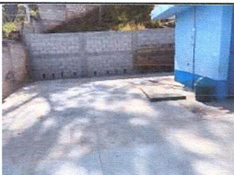
Foto 5: Sustitución de Cuneta de Concreto en Patio
