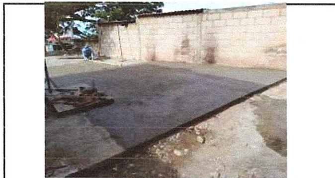
Foto 6: Sustitución de Cuneta de Concreto en Patio
