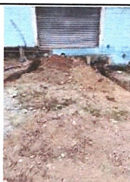
Foto 10: Instalación de Portón de Metal de 2.90 mts de Ancho por 2.30 de Alto. Después de la demolición se piensa instalar el porton antes mencionado para que los educandos tengan su propia entrada.
