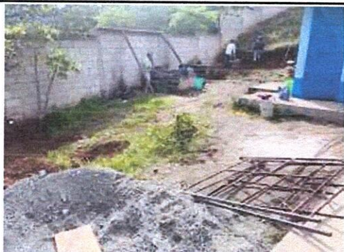
Foto 9: Demolición de Muros de Entrada Principal para poder instalar un portón de metal ya que el centro educativo no cuenta con entrada principal y los niños les toca ingresar por la entra de la escuela primaria.
