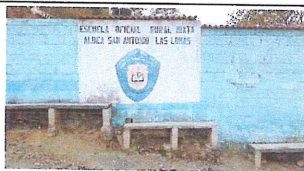
Foto 10: Instalación de Portón de Metal de 2.90 mts de Ancho por 2.30 de Alto. Despues de la demolición se piensa instalar el porton antes mencionado para que los educandos tengan su propia entrada.
