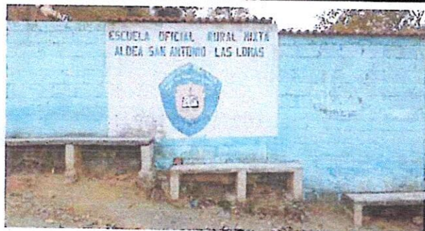
Foto 9: Demolición de Muros de Entrada Principal para poder instalar un portón de metal ya que el centro educativo no cuenta con entrada principal y los niños les toca ingresar por la entra de la escuela primaria.
