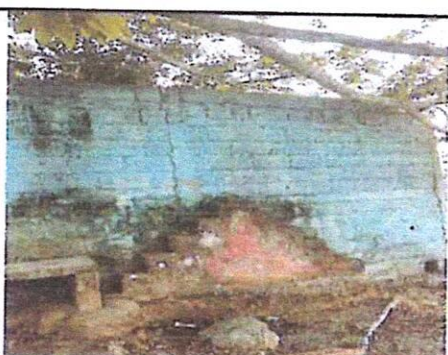
Foto 11: Sustitución de Muro de Block. El muro presenta deterioro severo por humedad manchas oscuras y estructura adosa dañada, por prioridad de los e estudiantes es necesario sustituirlo.
