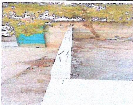
Foto 7: Instalación de Malla y Tubo Proceso en Patio. Esta intervención busca cerrar el área del patio, mejorando la seguridad y delimitación del espacio escolar.
