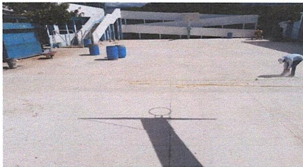
Foto 3: Finalización del fundición de 448 mts. Cuadrados de torta de cemento en cancha polideportiva: INEB JM. San Diego.
