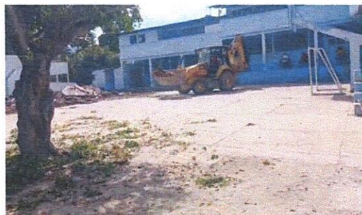
Foto 3: durante la ejecución del proyecto, compactación, y fundición de torta de cemento de cancha polideportiva INEB JM. San Diego.
