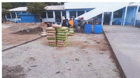
Foto 5: durante la ejecución del proyecto, compactación, y fundición de torta de cemento de cancha polideportiva INEB JM. San Diego.
