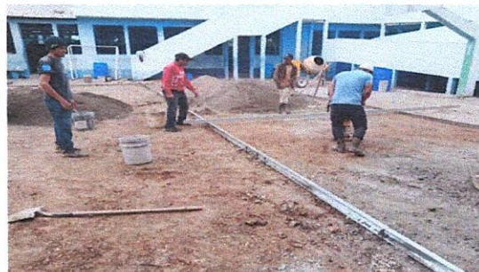
Foto 6: durante la ejecución del proyecto, compactación, y fundición de torta de cemento de cancha polideportiva INEB JM. San Diego.
