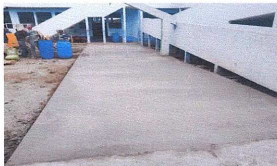
Foto 4: durante la ejecución del proyecto, compactación, y fundición de torta de cemento de cancha polideportiva INEB JM. San Diego.
