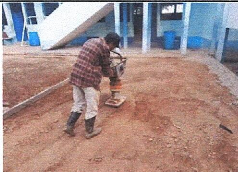
Foto 1: durante la ejecución del proyecto, compactación, y fundición de torta de cemento de cancha polideportiva INEB JM. San Diego.
