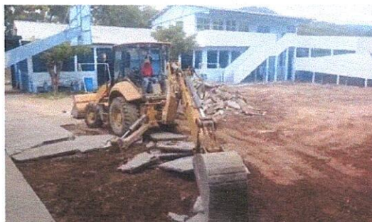
Foto 2: durante la ejecución del proyecto, compactación, y fundición de torta de cemento de cancha polideportiva INEB JM. San Diego.
