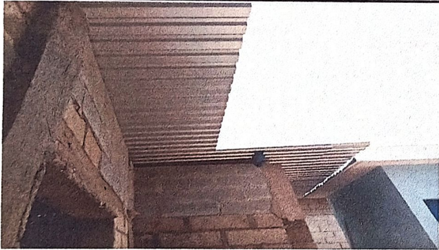
Foto 3: Sustitución de lámina ondulada por lámina troquelada calibre 26 Aluzinc, sustitución de estructura de madera por soporte de metal. Levantado de 3 hiladas de block.
