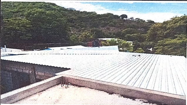
Foto 2: Sustitución de lámina ondulada por lámina troquelada calibre 26 aluzinc
