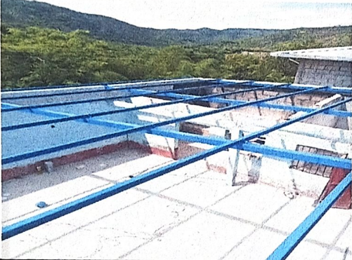
Foto1: Sustitución de estructura de madera por soporte de metal
