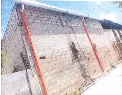
Foto 6: Bajadas de agua pluviales.
