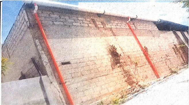
Foto 5: Instalación de canal de metal.
